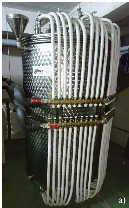
Slika 2.1. Latentni spremnik topline cijevne konfiguracije s lamelama, a) razmatrani latentni spremnik topline, b) konfiguracija cijevi i lamela unutar spremnika
